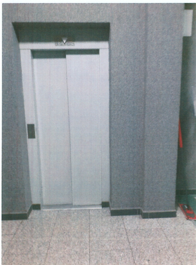
Zdj. nr 7 – Wejście do windy na poziomie I piętra
