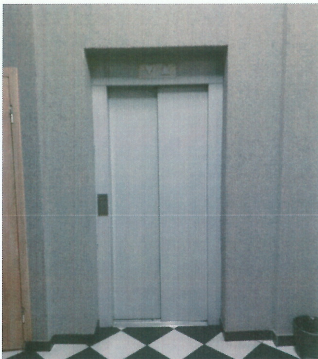
Zdj. nr 7 – Wejście do windy na poziomie parteru
