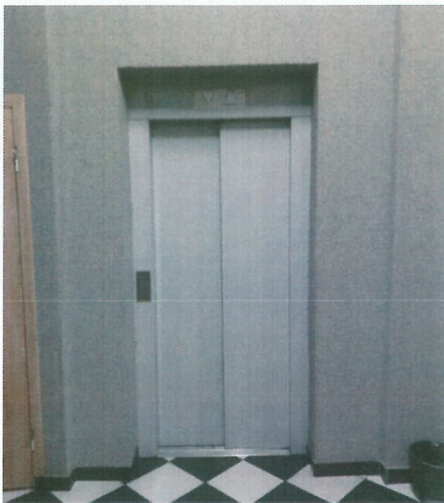
Zdj. nr 7 – Wejście do windy na poziomie parteru
