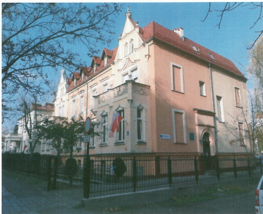
Zdj. nr 1 – Elewacje budynku od ulicy Andersa.
